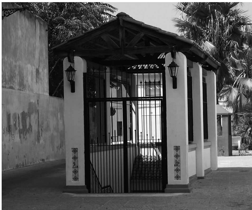
Aspecte exterior de la Cisterna. Any 2004
