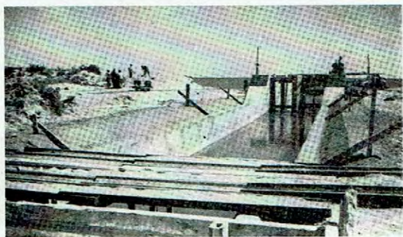
Canal per a la canalització i desaiüe de les partides arrosseres. Vista presa envers la desembocadura
