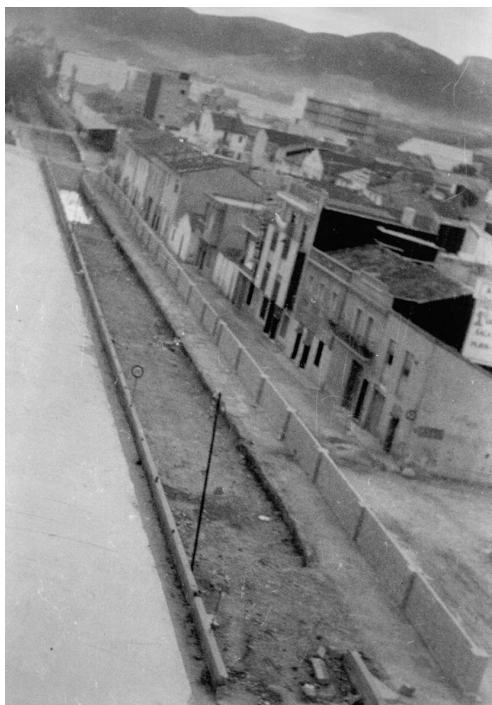
Excavació del túnel. Xeraco
