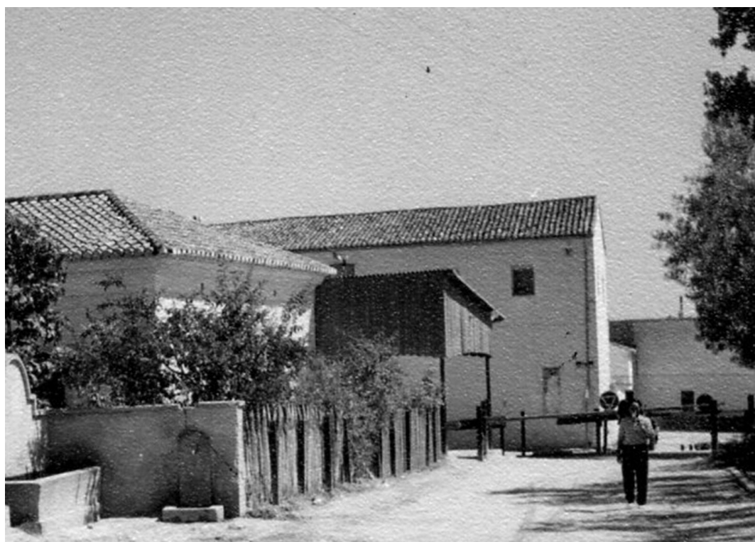
Pas a nivell del camí de les Fonts. Estació de Xeraco
